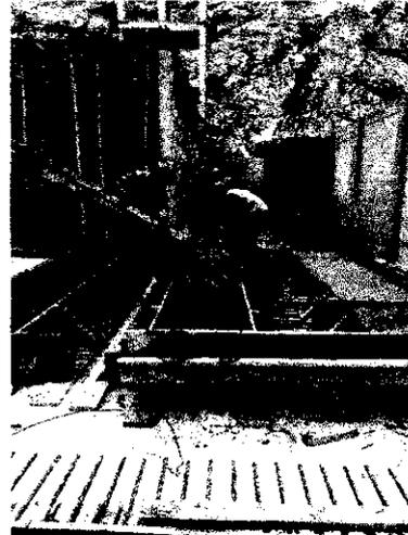
Fotografía N°04: vaciado de losas prefabricadas.
