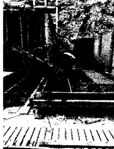
Fotografía N°04: vaciado de losas prefabricadas.
